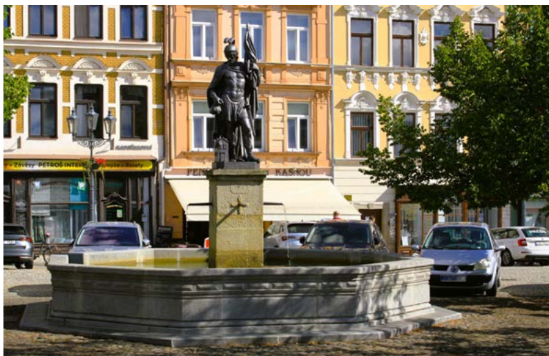
Kašna je složena z částí různého stáří
