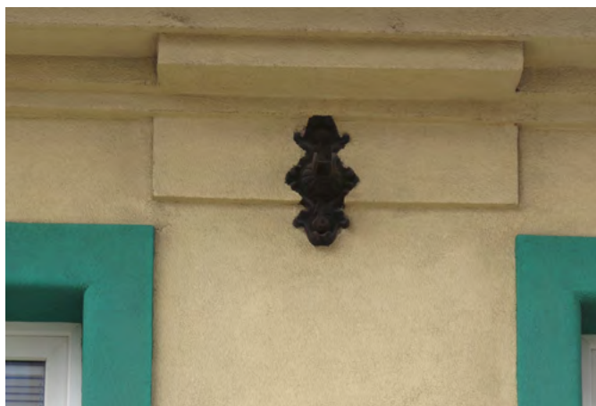
Z původní Křižíkovy Elektrické dráhy Praha – Libeň – Vysočany se do současnosti dochovalo několik závěsů trolejového vedení (tzv. „růžic“). Snímek ze 7. února 2024 dokumentuje jednu takovou růžici v Zenklově ulici poblíž Palmovky.
