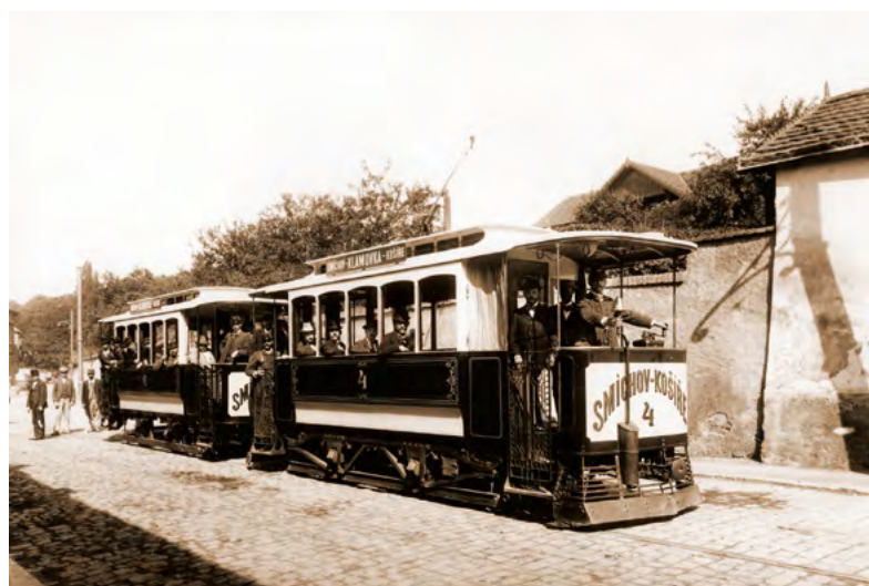
Souprava motorového vozu ev. č. 4 a vlečného vozu ev. č. 6 Hlaváčkovy Elektrické dráhy Smíchov – Košře během zkušební jízdy. Vzhledem ke slabému výkonu motoru v tažném (motorovém) voze nebyl provoz s vlečnými vozy povolen. Záběr byl pořízen na Klamovce v červnu 1897.
