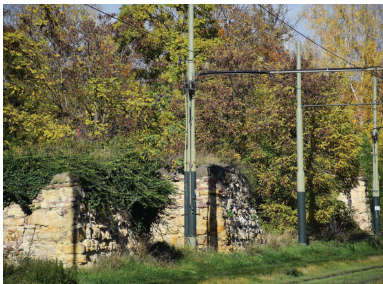
Pozůstatky barokního opevnění severně od bašty sv. Františka Borgii
