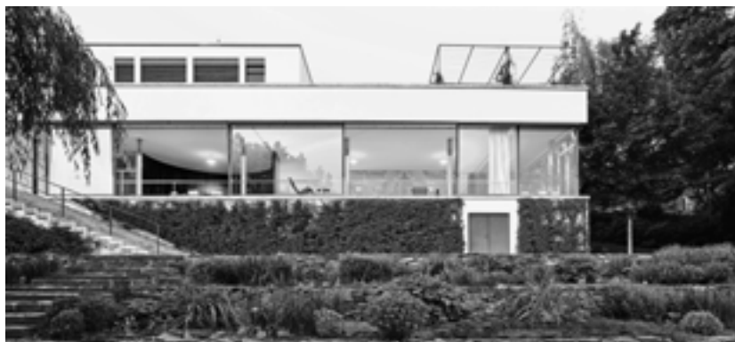
Obr. 1 Vila Tugendhat po rekonstrukci. Pohled ze zahrady ukazuje „skleněný pokoj“ se zakřiveným jídelním prostorem, pochromované ocelové nosné sloupy a onyxovou stěnu. Fotografie od Davida Židlického s využitím www.tugendhat.eu/en
