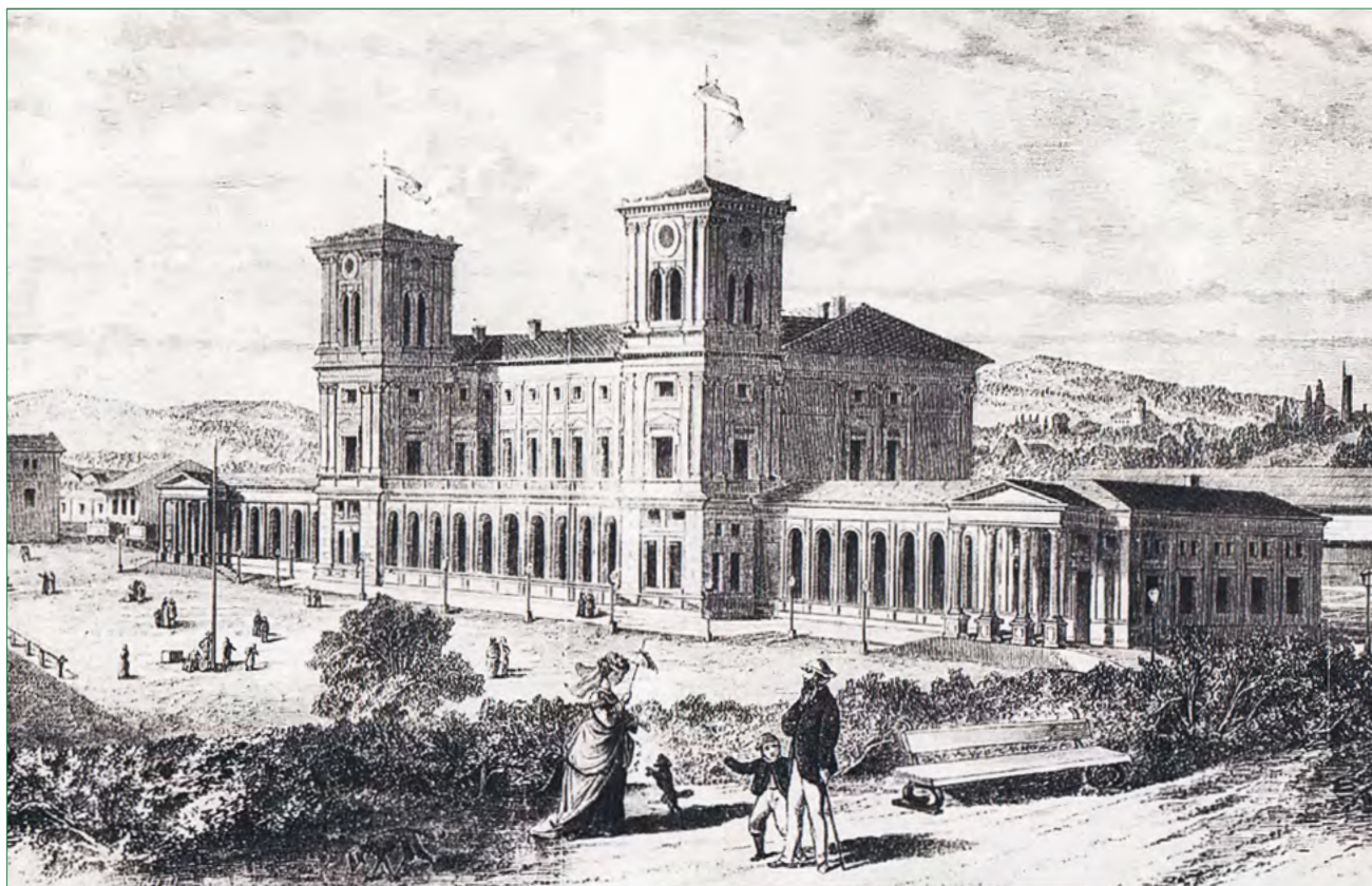
Novorenesanční budova nádraží Františka Josefa od arch. A. V. Barvitia postavená v letech 1869–1871, sbírka autor
