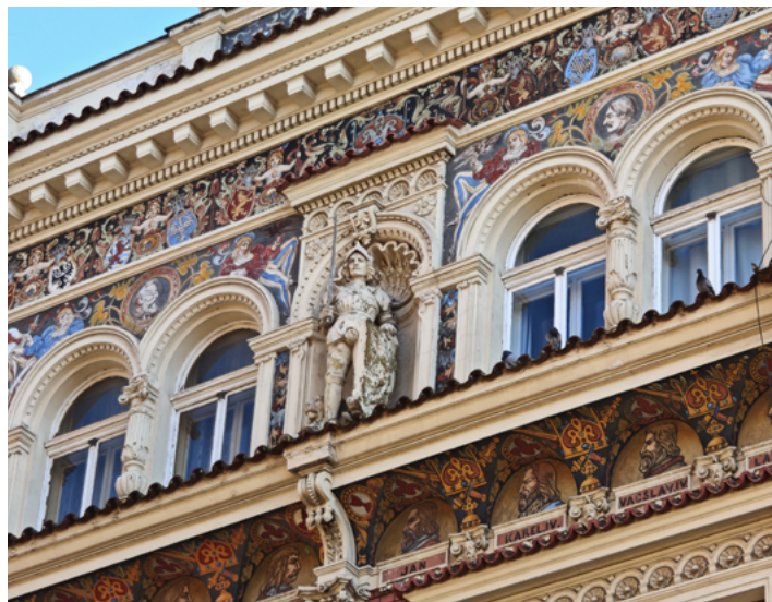
Detail zdobné fasády domu číslo 256 v Solní ulici
